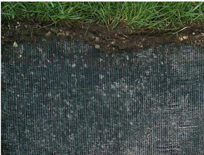
Abb. 4: Beispiel für eine horizontale Maulwurfbarriere. (Foto: Nonn)
