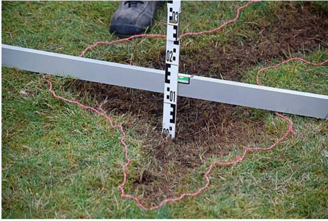
Abb. 3: Nicht ungefährlich, Absenkungen im Rasen durch Maulwurfgänge. (Foto: Ludwig)
